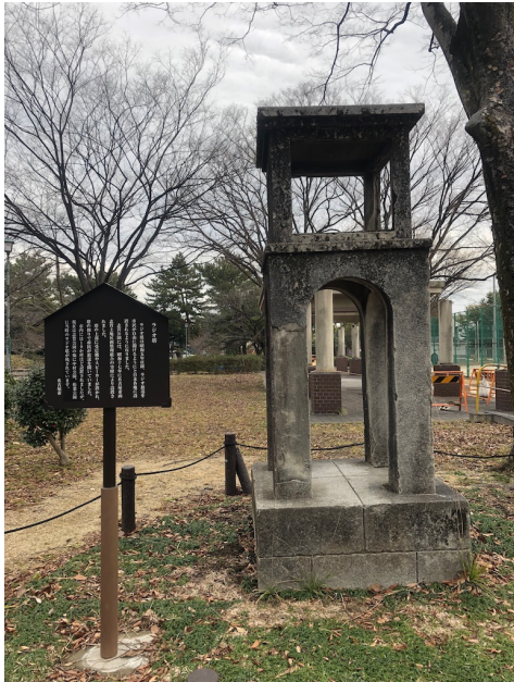
図1 志賀公園のラジオ塔 (2019年2月3日筆者撮影)
