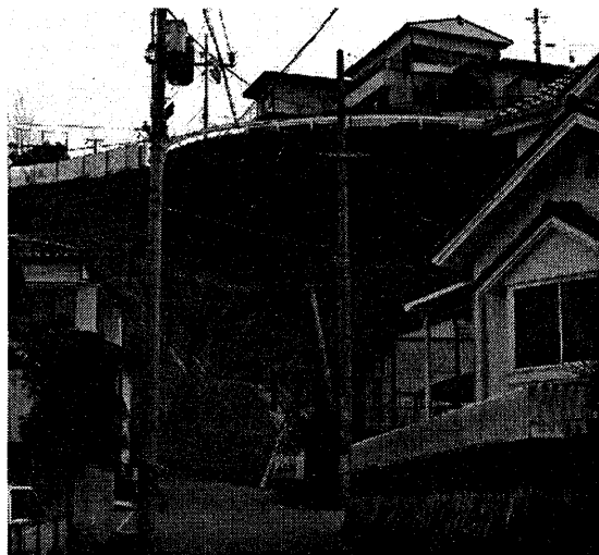
写真-2 広島市安佐南区相田 Photo-2 Damage site at Hiroshima
