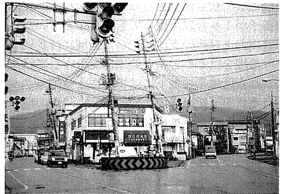
写真-2 傾いたままの電柱
