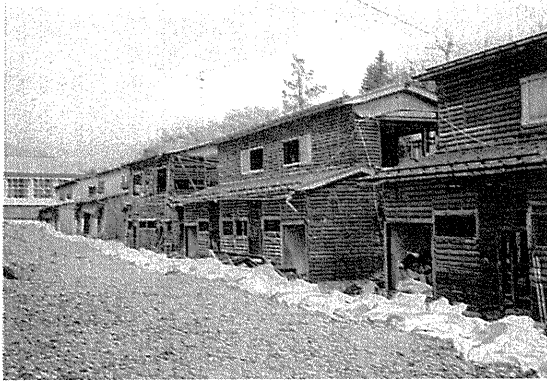
写真-11 長岡市の被災住宅
