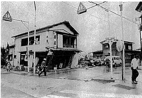
写真-5 川口町の被災住宅 1
