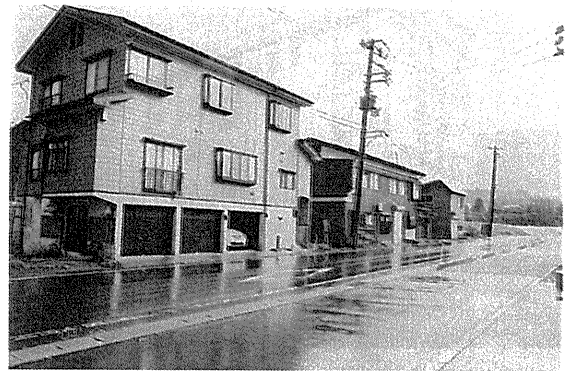
写真-8 RC高基礎形式住宅
