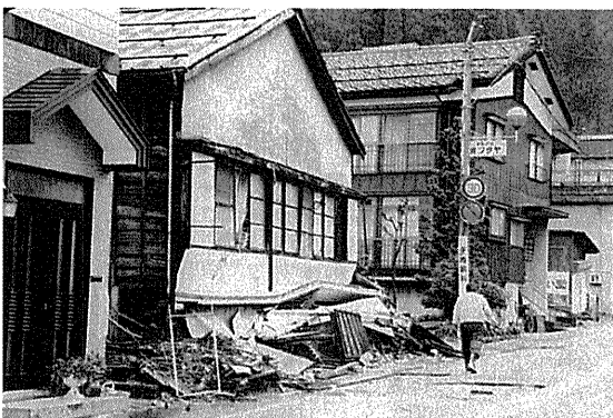
写真-6 川口町の被災住宅 2)
