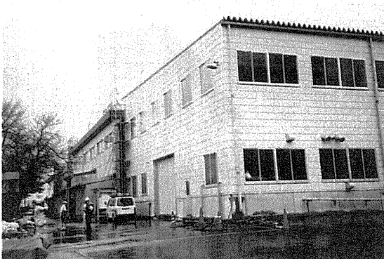
写真-13 小千谷市内の鉄骨造工場
