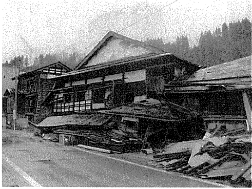
写真-4 川口町の被災住宅
