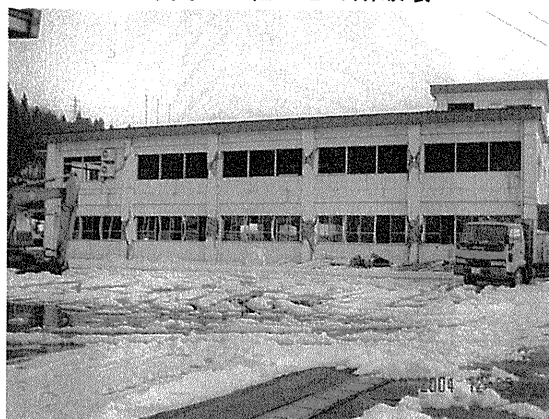
写真-24 解体直前の様子
