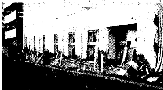
図1 兵庫県南部地震による柱脚部の被害状況
