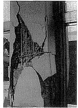
写真5, 6 溝口町役場全景, および1階外柱のせん断破壊
