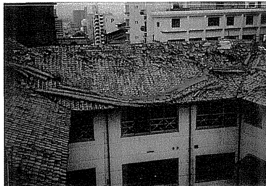
写真 32 ホテルの屋根瓦の損傷（松山市）
