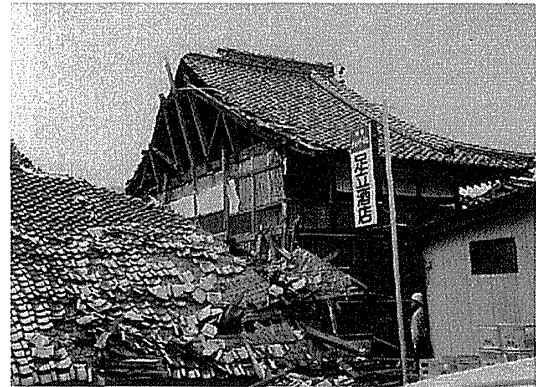
写真2 上道神社の倒壊（側面）
