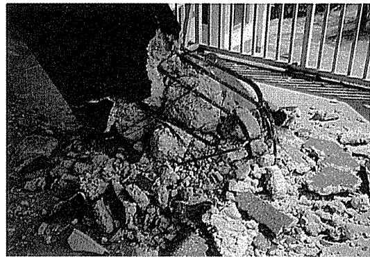
写真 22 2階柱脚の破壊
