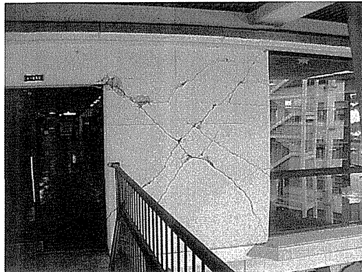
写真 29 図書館2階の壁せん断ひび割れ（広島市）
