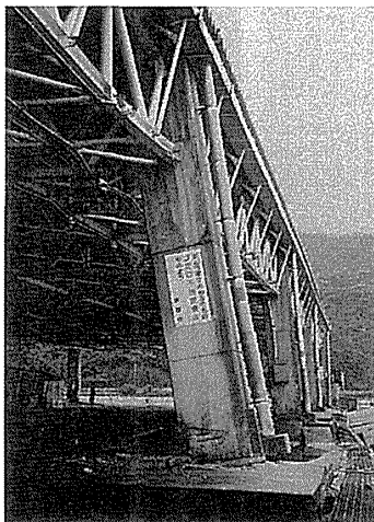
写真 13 境港水産物地方卸売市場 柱の側方流動
