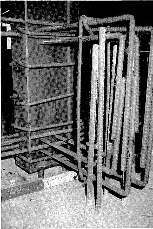
写真-1 柱脚部分の配筋 (No. 2-B)
