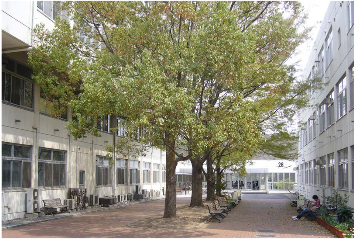
生命工学部中庭と 28 号館（平成 23 年春）
